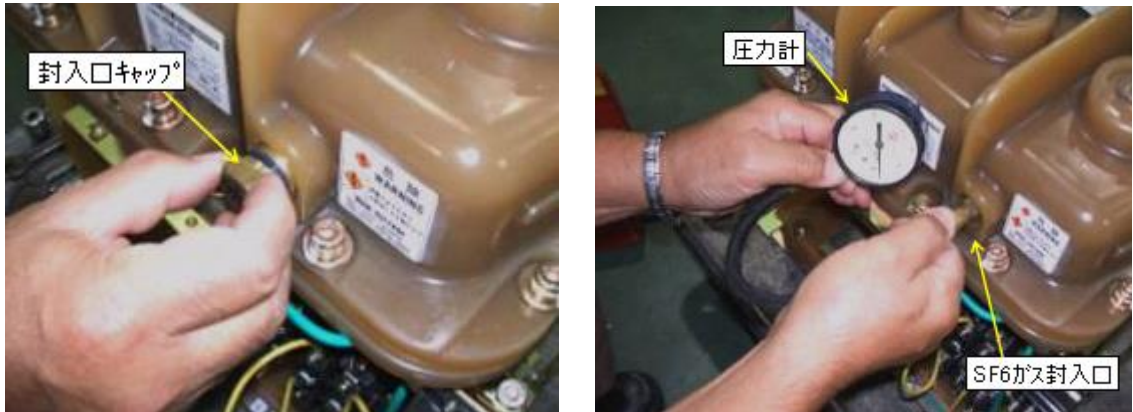
写真2 (例)ガス圧力測定方法
